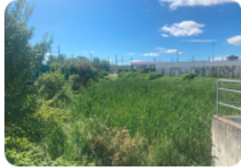
Bassin d'orage pour la rétention des eaux pluviales de Dijon TER
